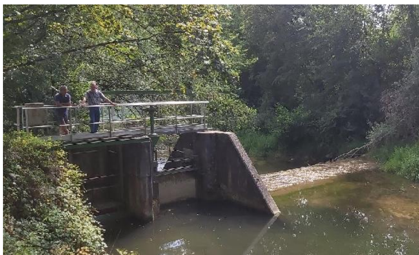
Figure 15 : Prise d'eau sur le Furand – Station de pompage de Saint-Lattier
